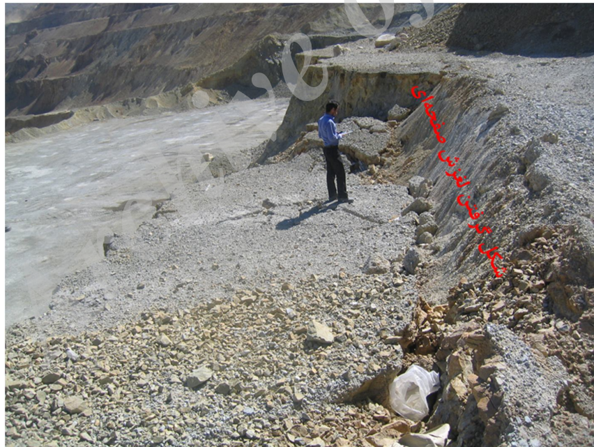
شکل 3: لغزش صفحه‌ای در افق 2550 دیواره غربی
