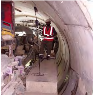
شکل ۷: اندازه‌گیری سرعت جریان هوا در مقاطع مختلف توسط بادسنج مینی پره‌ای
