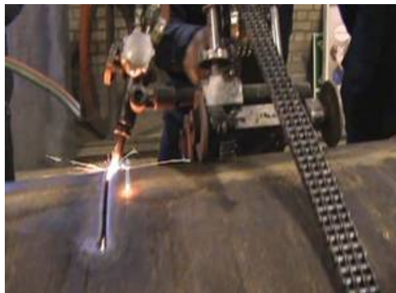
شکل 1 برش کاری لوله
