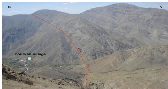
شکل ۲: نمایی از گسل پورکان - وردیج در مسیر تونل
