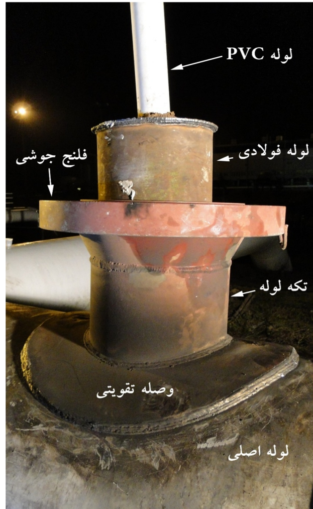
شکل 2 - تجهیزات بکاررفته در عملیات تعمیر نشتی
