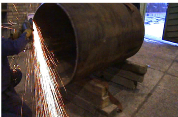
شکل ۲- آماده سازی لوله
