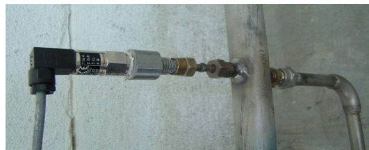
شکل ۳- حس گر فشار ۴۰۰ بار در ابتدای خط
