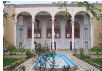
شکل ۲۴ سرمایش ایستا با ایجاد حوض آب و فضای سبز در حیاط خانه قدکی.
