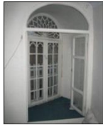
شکل ۱۸ ساخت پنجره مضاعف در خانه بهبودی تبریز.
