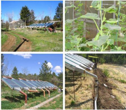
شکل ۱۰- گلخانه‌ای مجهز به جمع‌کننده‌های حرارتی خورشیدی صفحه مسطح و خطوط لوله گردش هوا [۸].
