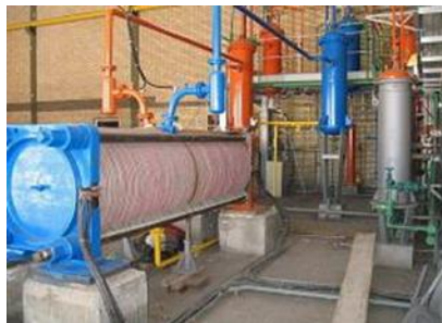
شکل ۱۰ الکترولیز ۲۰۰ کیلووات نیروگاه طالقان [۵۵]
