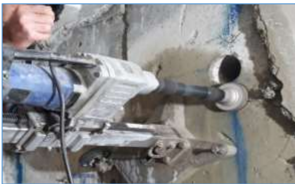
شکل ۱. تصویرهایی واقعی از مته سوراخ‌کاری بتن (کر گیری) [۱۳ و ۱۴]
