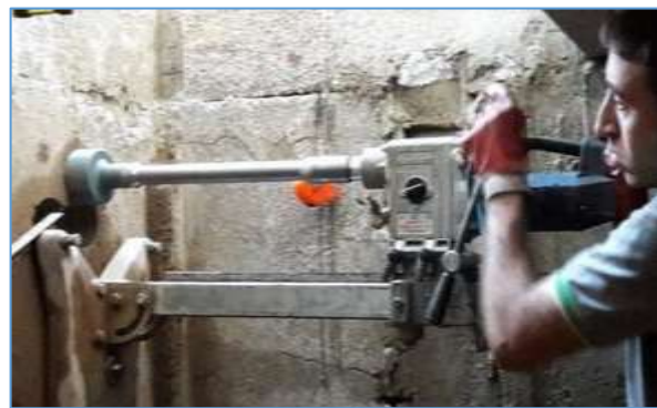
شکل ۱. تصویرهایی واقعی از مته سوراخ‌کاری بتن (کر گیری) [۱۳ و ۱۴]
