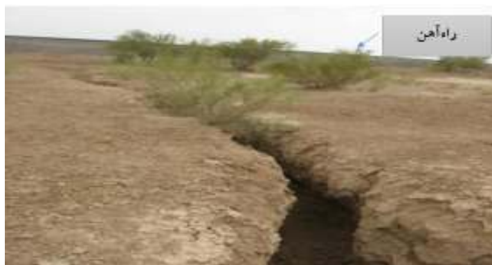
شکل ۱. خاک رهنده - ترک عمودی در نزدیکی راه آهن در دشت سمنان
