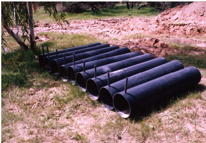
شکل ۱- آماده سازی لوله‌های پلی اتیلن برای آزمایش آبیویی در شرایط مزرعه
