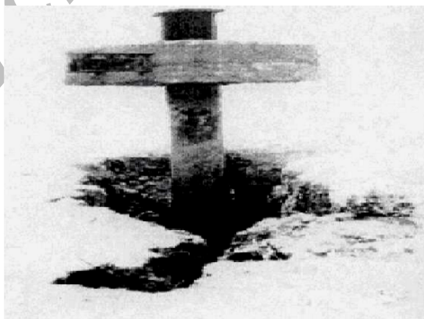
شکل ۱- الف- نشست زمین پیرامون لوله جدار یک چاه آب در دشت رفسنجان [۲۵]
