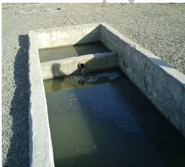
شکل ۱- هاضم بی‌هوازی در ورودی و برکه بی‌هوازی در ادامه
