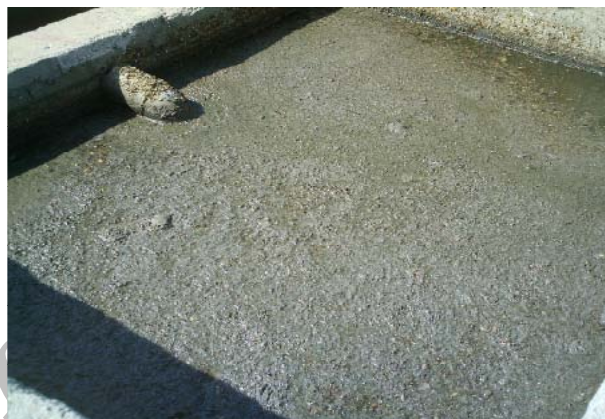
شکل ۲- تجمع چربی، روغن و لجن در سطح هاضم بی‌هوازی
