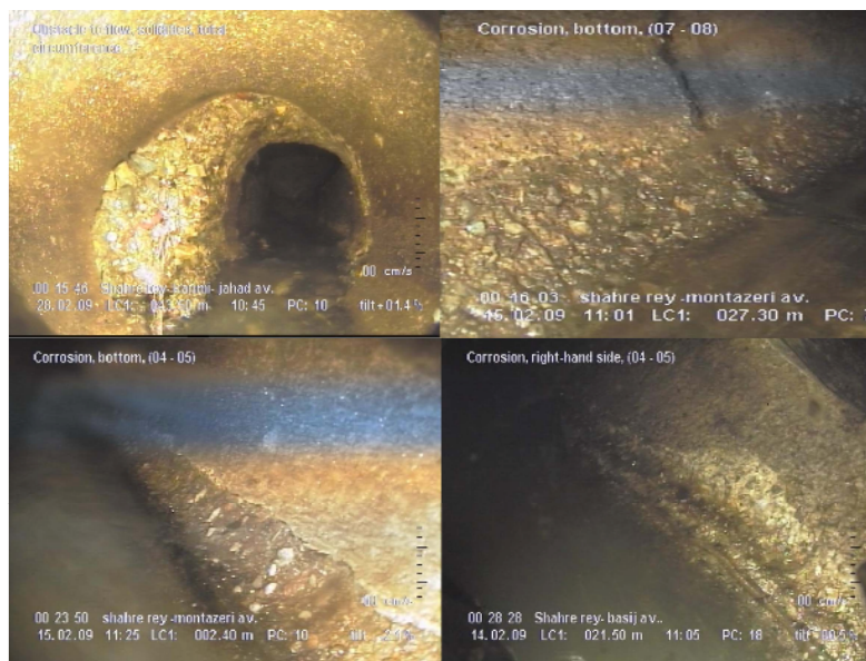
شکل ۴- نمونه از خوردگی های موجود در شبکه جمع آوری فاضلاب شهرری که توسط سیستم تلویزیون مدار بسته در حین بررسی بصری شبکه گرفته شده است
