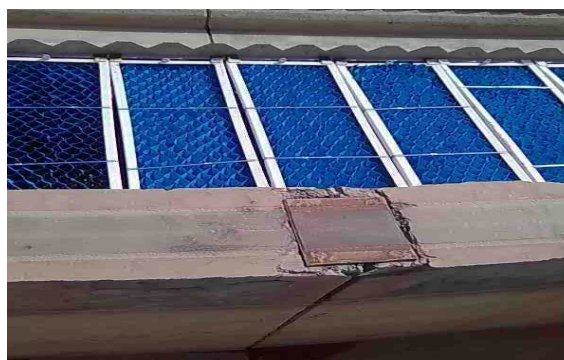
شکل ۲- نمایی از حوض ته‌نشینی مجهز شده به سیستم لاملا
