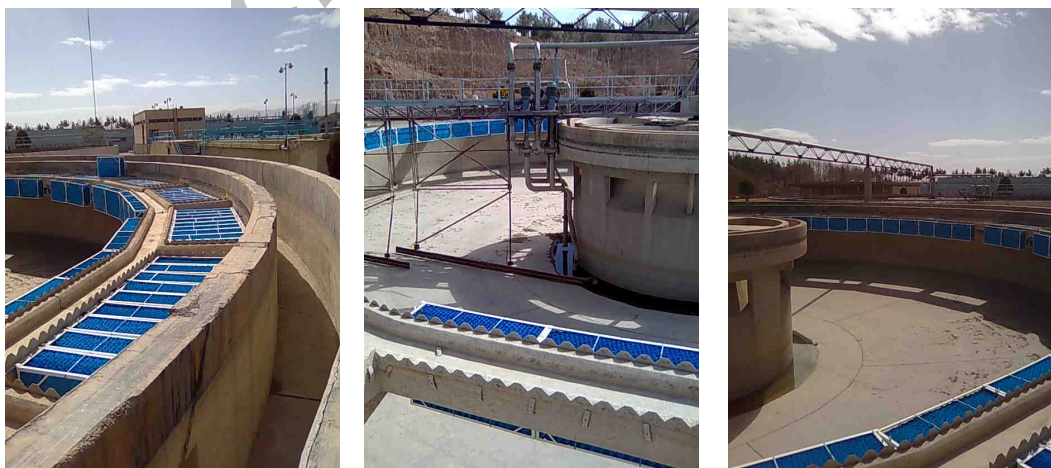
شکل ۵- نصب طرح به صورت صنعتی در کلاریفایر ۱ تصفیه خانه آب اصفهان
