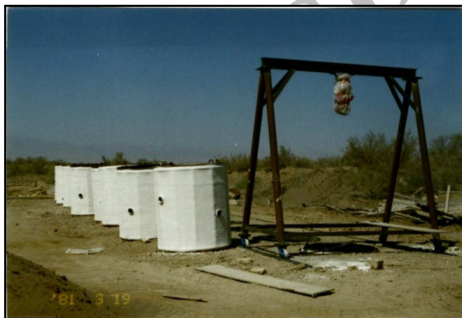
شکل ۲- آماده سازی لایسیمترها برای نصب در محل اصلی
