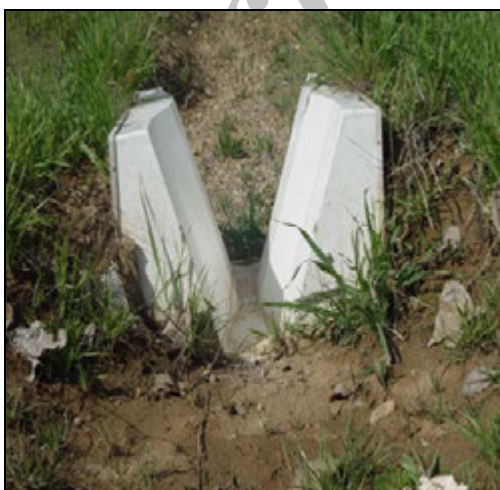
شکل ۱- نمایشی از یک ورودی آب مقطع سیمانی (راست) و یک فلوم W.S.C. تیپ ۳ (چپ)
