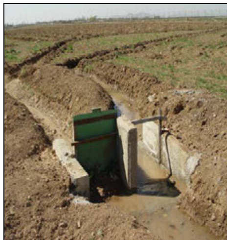
شکل ۱- نمایشی از یک ورودی آب مقطع سیمانی (راست) و یک فلوم W.S.C. تیپ ۳ (چپ)
