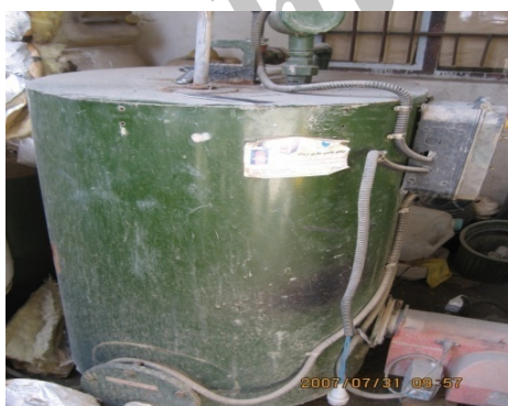
شکل ۲- مخزن ذخیره آب و تولید بخار
