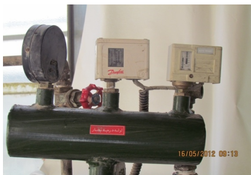
شکل ۶- سیستم فرمان کنترل سطح و فشار بخار
