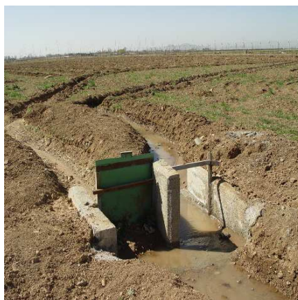
شکل ۱- نمایی از یک ورودی آب مقطع سیمانی (راست) و یک فلوم W.S.C. تیپ ۳ (چپ)
