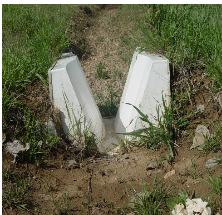
شکل ۱- نمایی از یک ورودی آب مقطع سیمانی (راست) و یک فلوم W.S.C. تیپ ۳ (چپ)
