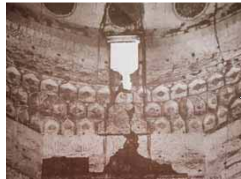
شیوه چیدمان تاسه‌ها در چپیره‌سازی گنبدخانه مسجد جامع ارومیه
