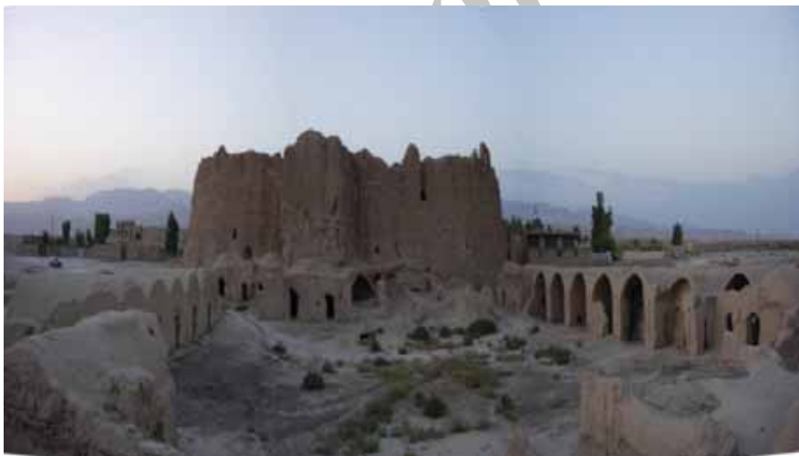
تصویر شماره ۳: نمای جنوبی مجموعه بناهای ده نمک و دژ ده نمک (Authors)
