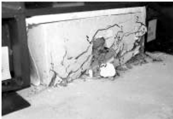
شکل ۲. مود شکست بلوک برشی بتنی [۴].
