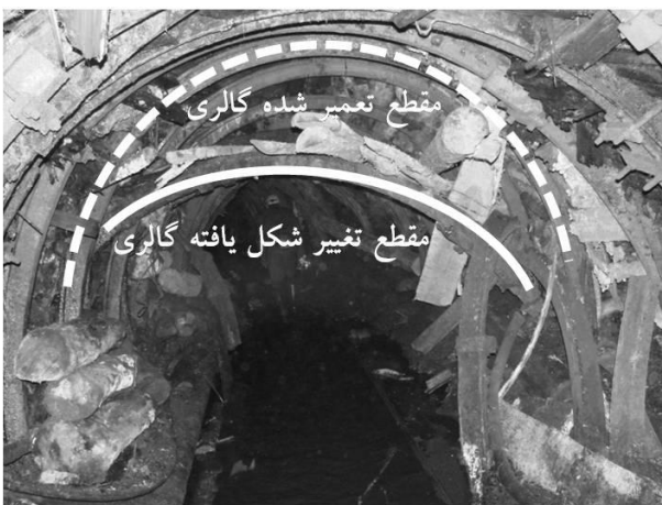
شکل 3: نمایی از قسمت تعمیر شده گالری پست
