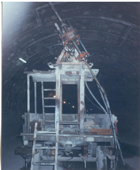
شکل 6: حفر گمانه جهت مغزه گیری و اجرای آزمایش لوزان خط 2 تونل متروی تهران S 2 -X 2 در قطعه
