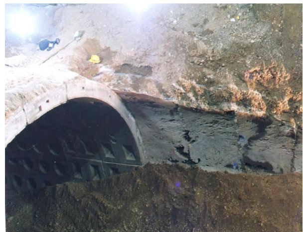
شکل 4: زون خاک تزریق شده در عملیات تزریق قطعه S 2 -X 2
