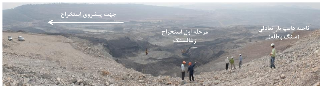
شکل ۱۹: تصویری از انجام عملیات استخراج زغالسنگ در دیواره شمال شرقی با اعمال تکنیک بار تعادلی به منظور حفظ پایداری دیواره
