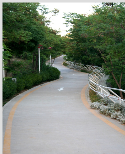
شکل ۱۲- قوس افقی مرکب متشکل از قوس معکوس S در ترکیب با قوس دایره‌ای ساده در پیست دوچرخه سواری بانوان، بوستان بهشت مادران (منبع: نگارنده)
