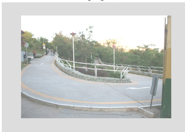
شکل ۱۱- قوس افقی دایره ای ساده برای ارتباط دو مسیر مستقیم رفت و برگشت در پیست دوچرخه سواری بانوان، بوستان بهشت مادران (منبع: نگارنده)
