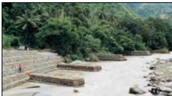
شکل 1 نمونه‌ای از آب‌شکن متخلخل اجرا شده در ایران (خسروی، 1393)
