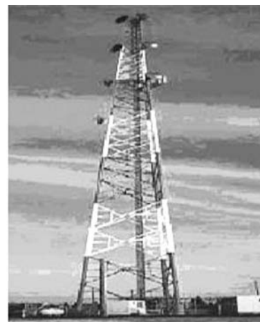
الف) برج مشبک فلزی. [۱]
