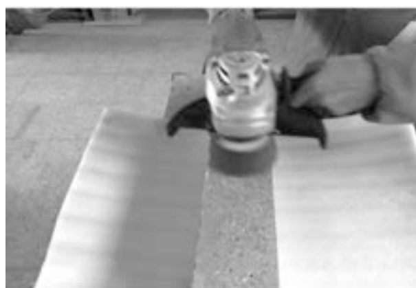
شکل ۳. استفاده از دستگاه فرز به منظور آماده‌سازی سطحی.
