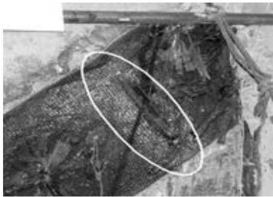
شکل ۳. مهارهای منگنه‌بی پس از نصب.
