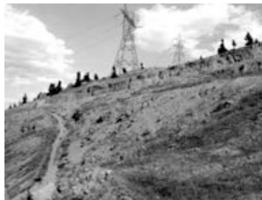
شکل ۱. محل وقوع لغزش در نزدیکی دکل برق فشارقوی.
