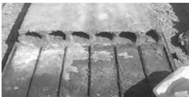
الف) نمای نزدیک از دال مجوف بتنی (بتن معمولی) پس از اجرای عملیات جک زدن، بتن ریزی و قبل از تنیدن دال؛
