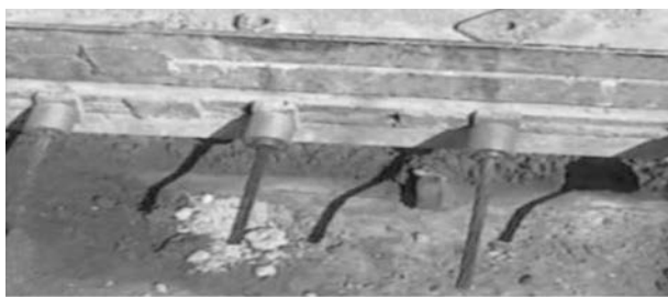
الف) نمایی از نحوه ی عبور فولادهای پیش تنیده در قفل و بست های انتهایی در تکیه گاه های مدفون شده در زمین که در صنعت از آن استفاده شده است؛
