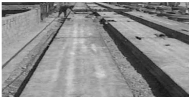
ب) نمایی از بستر دال های مجوف بتنی (بتن معمولی) پس از عملیات جک زدن، بتن ریزی و قبل از تنیدن دال.
