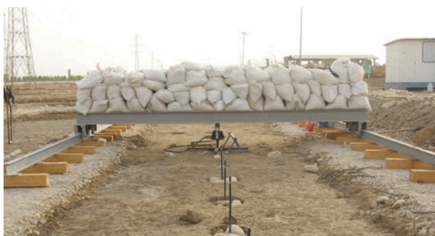
شکل ۲. تصویر سیستم متحرک گاری و ریل‌ها روی مسیر آماده‌سازی شده.
