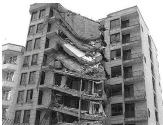
شکل ۱. فروریزش ساختمان ۷ طبقه‌ی سعادت آباد تهران (۱۳۸۷). [۴]
