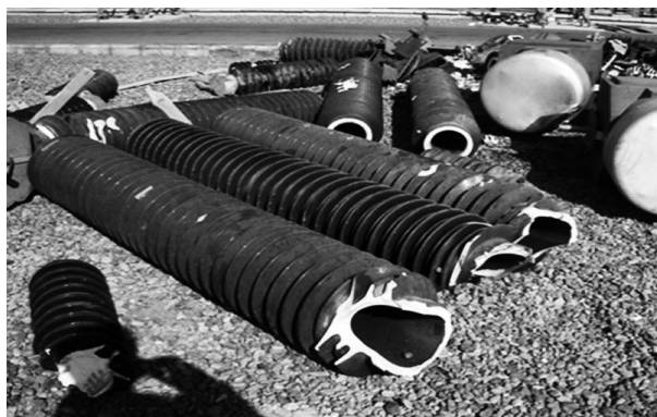
شکل ۱. شکستگی مقره‌ی تجهیزات پست برق (زلزله‌ی بم، ۱۳۸۳).
