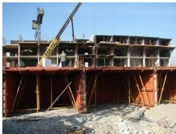
شکل ۱. قالب‌بندی ساختمان بتنی قالب‌تونلی.
