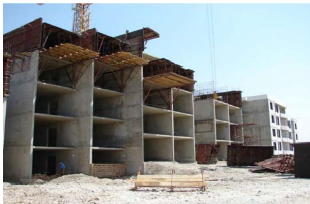
شکل ۱. نحوه‌ی قالب‌بندی ساختمان‌های قالب‌تونلی.
