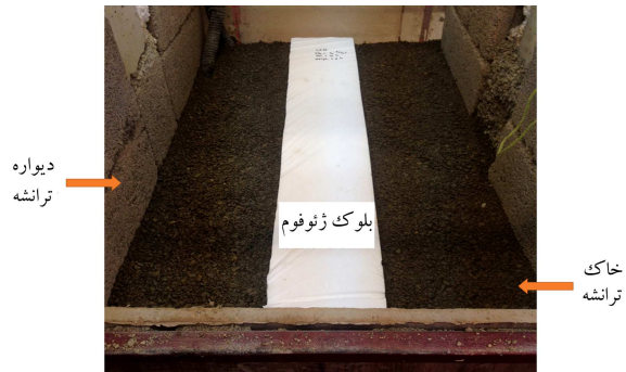
شکل ۴. تصویری از بلوک ژئوفوم واقع بر روی لوله‌ی مدفون در داخل ترانشه.
