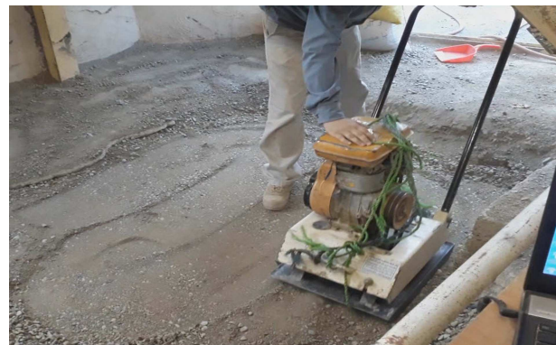
شکل ۵. تصویری از کوبیدن بستر با فشرده ساز بنزینی.
