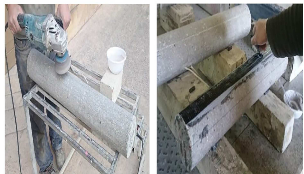
شکل ۲. تقویت به روش EBR.
