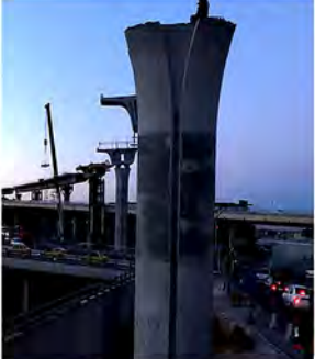
الف) پایه نگهدارنده پل سگمنتی؛ ب) محل قرارگیری حسگر شتاب سنج. شکل ۱۰. پایه پل سگمنتی و محل قرارگیری حسگر بر روی آن.
