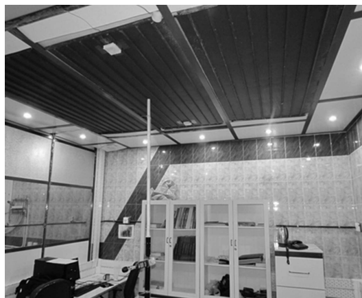
شکل ۱. نمونه‌یی از پانل سرمایش تشعشعی هیدرونیك مورد مطالعه در آزمایشگاه مهندسی حرارتی دانشگاه تربیت مدرس.
