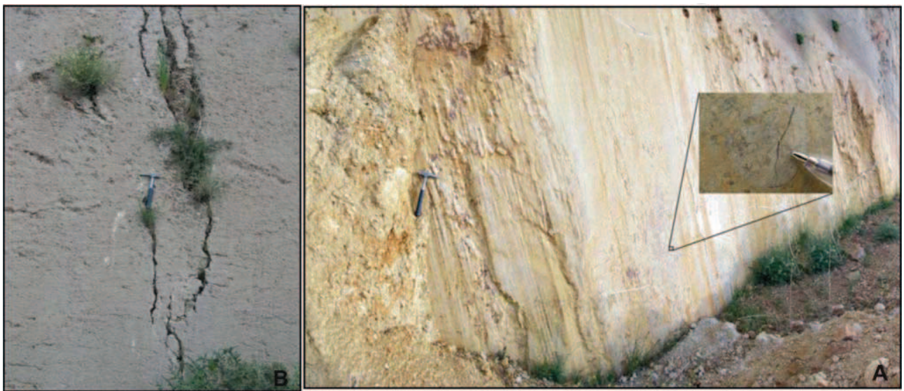
شکل ۱۲. (A) فاز اول سبب ایجاد شکستگی و گسل های اصلی و درزه هایی با پرشدگی و سیمان در دیواره گسلی ارژن باختری شده است (جهت دید ناظر رو به شمال باختر و B) فاز دوم سبب ایجاد درزه های جوان شده است (جهت دید ناظر رو به شمال خاور).
