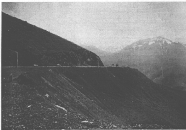
شکل شماره ۲۰. تصویر پیچ تند کیلومتر ۱۶+۷۰۰ و نبود هیچ گونه زرده‌ی محافظ
