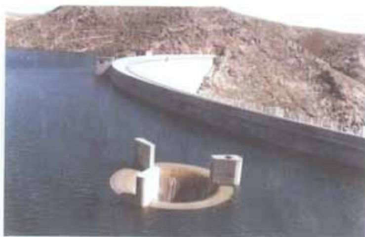
شکل شماره ۲ - نمای از سد طرق
