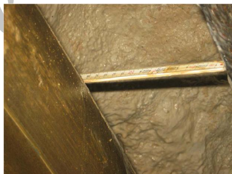
شکل ۲. سایش ثانویه شدید در حد فاصل پشت کله حفار و سپر یک ماشین حفاری مکانیزه از نوع فشار تعادلی خاک [۸]
