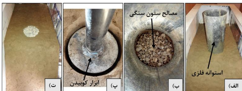
شکل ۶. مراحل اجرای ستون سنگی غیرمسلح: الف) فرو کردن استوانه فلزی داخل خاک، ب) ریختن مصالح ستون و کوبیدن مصالح در لایه‌های ۵ سانتی‌متری، پ) ستون اجرا شده در لایه یکی مانده به آخر و ابزار کوبیدن مصالح ستون، ت) ستون سنگی تکمیل شده
