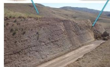
شکل ۲. نمونه‌هایی از زمین‌لغزش‌های رخ داده در قطعه ۵ راه آهن اردبیل-میانه
